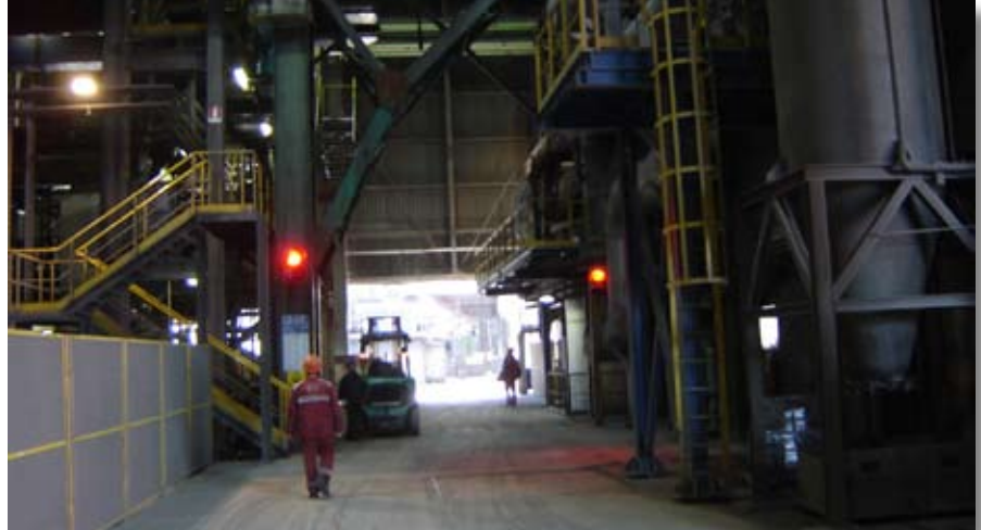
Prehod v proizvodnem obratu
