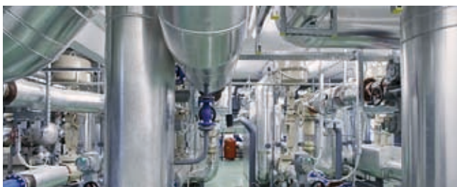
Rekonstrukcija »CEP« 70 MW, KP Velenje, 2007/2008
