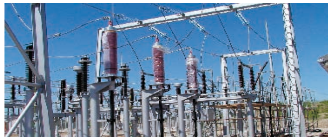
Rekonstrukcija RTP Krško 400/110 kV, Elektro-Slovenija, d. o. o., 2003
