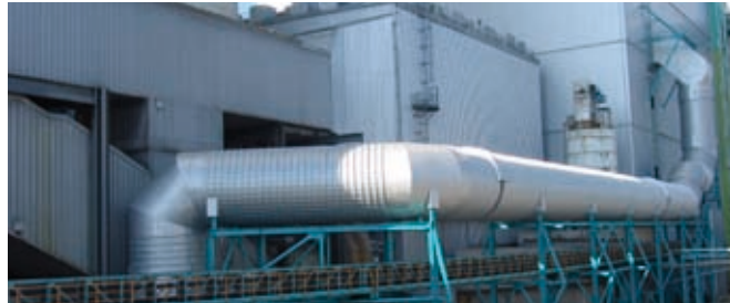
Rekonstrukcija kanalov dimnih plinov na bloku 5, TE Šoštanj, 2007
