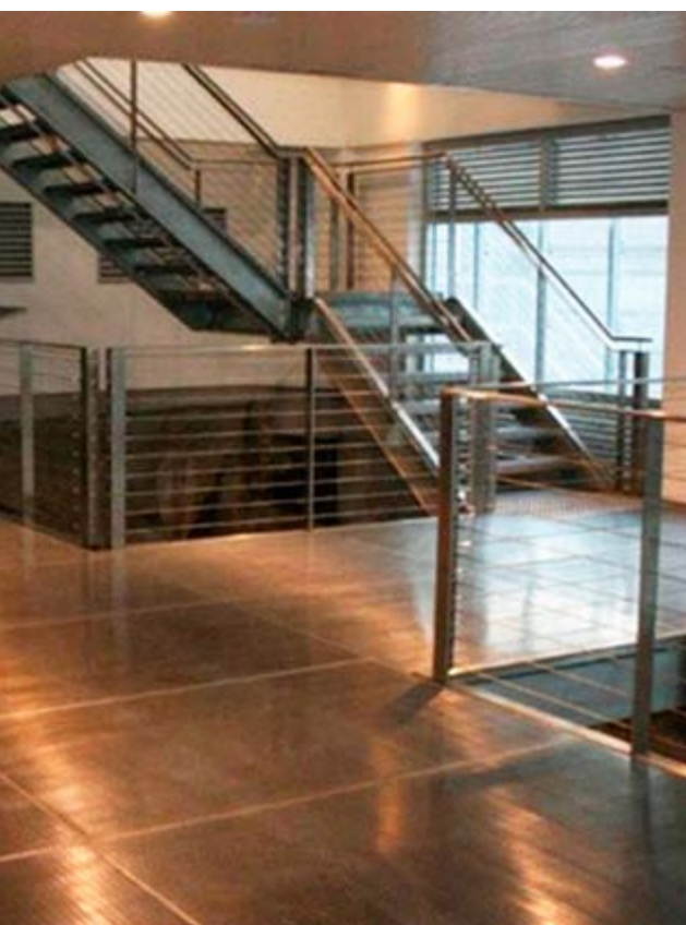
● Stopnišče iz nerjavnega jekla
