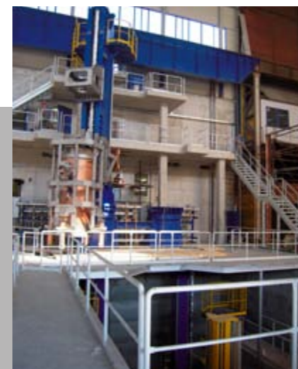
• Montaža prvega stebra za elektrodo
