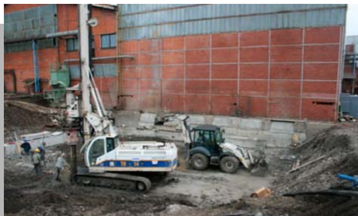
• Priprava gradbišča ter varovanje gradbene jame za tehnološke temelje EPŽ3-peči
