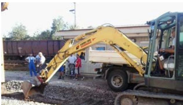
▲ Začetek gradbenih del
