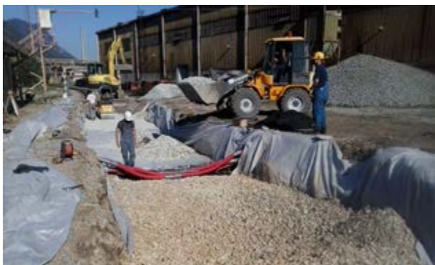
▲ Nasipanje in utrjevanje podlage
