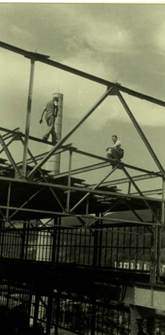
▲ Na nevarnih višinah – montaža hale nove jeklolivarne (1951)
