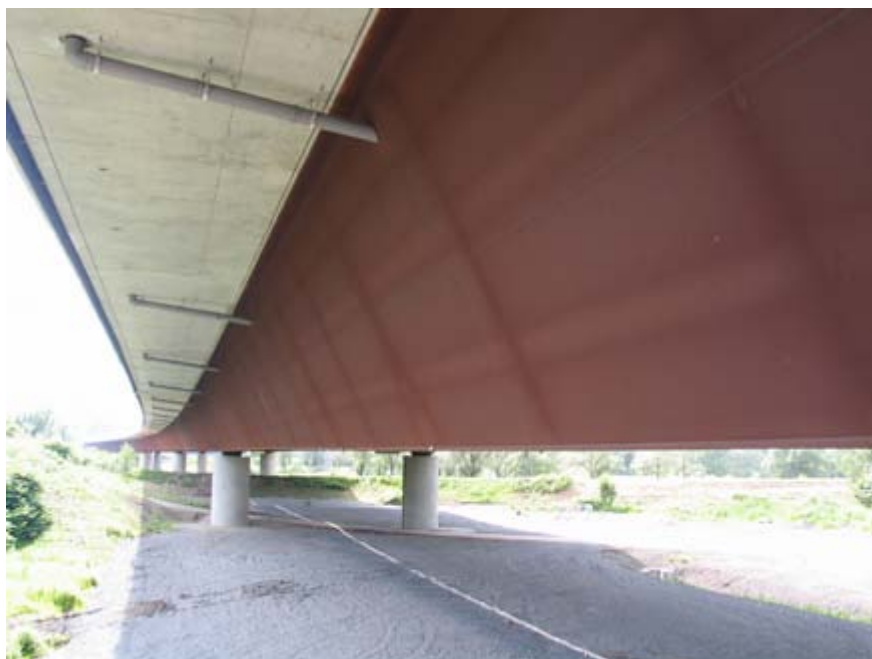
▲ Most, zavarjen z elektrodo EVB Cu Ni
