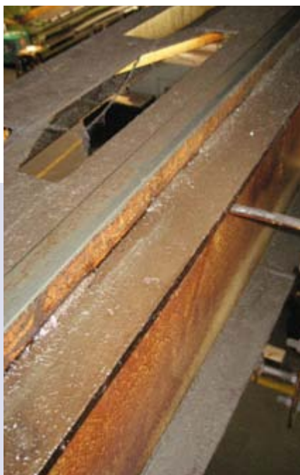
▲ Stara tirnica – varjena izvedba
