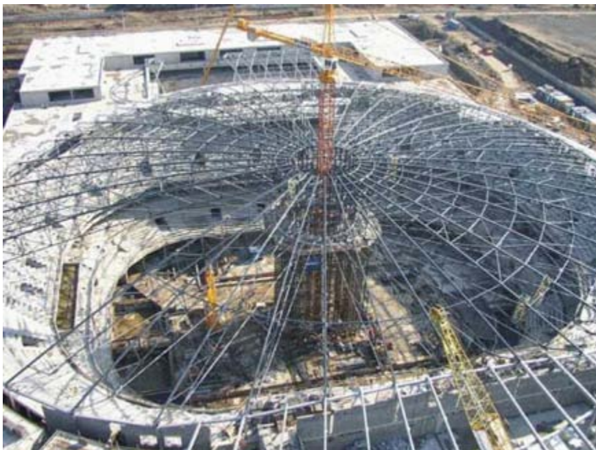
▲ Sazka arena, zavarjena z elektrodo EVB 50
