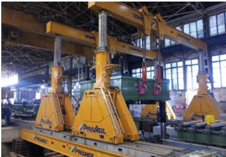
▲ Montaža 86 ton težkega zgornjega dela stroja
