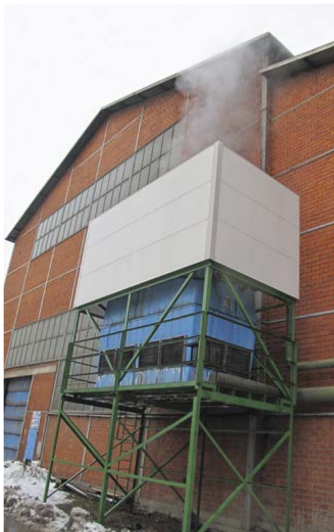
▲ Protihrupna zaščita hladilnega stolpa v Kovačnici
