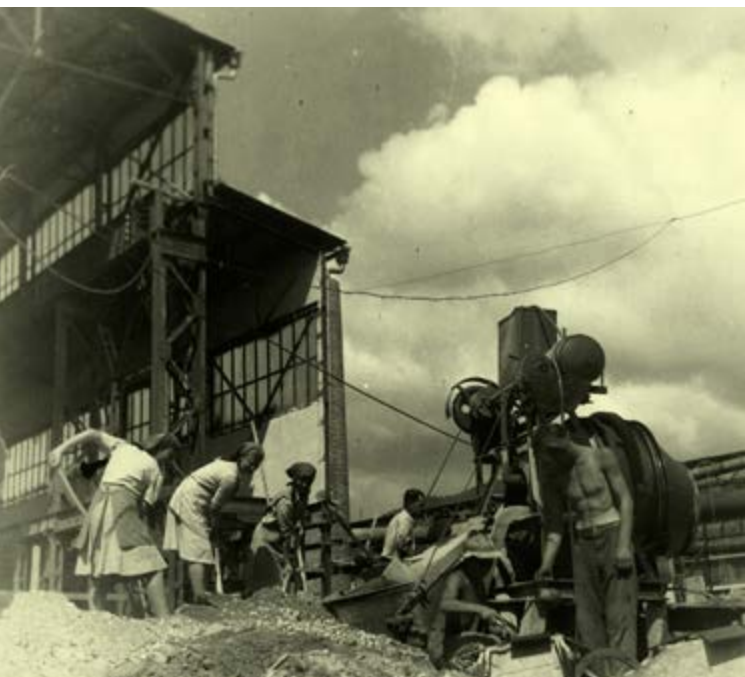
▲ Žene strežejo mešalniku za beton pri gradnji nove jeklolivarne
