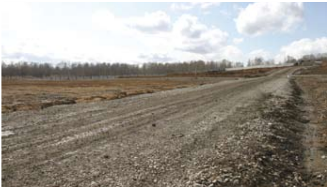
Na novo zgrajena cesta nas je pripeljala do rudnika.
